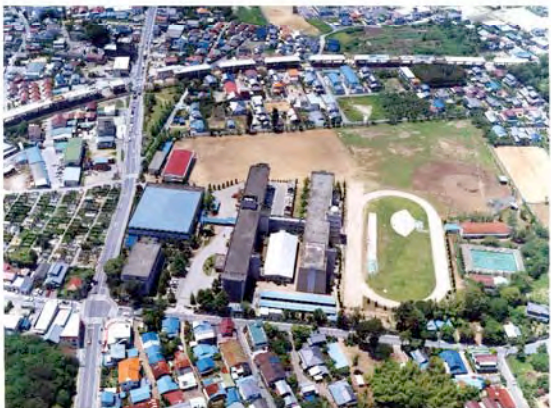
昭和60年 外房線高架工事中
