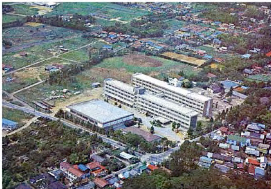
昭和46年 プール前旧校舎取り壊し中、第二棟完成時
