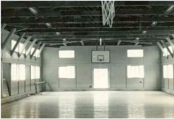
昭和33年改装なった旧体育館内部
