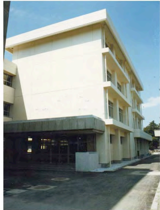
昭和62年第3棟増築
