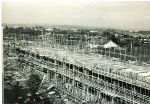
昭和45年建設中の新校舎2棟
